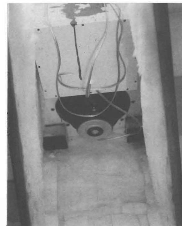
Particolare della cassa di figura 2. Deve risultare completamente sigillata rispetto al resto del diffusore
